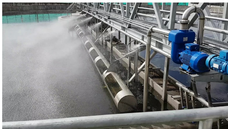
Diseño de recolección de espuma por medio de tubería rotativa.
