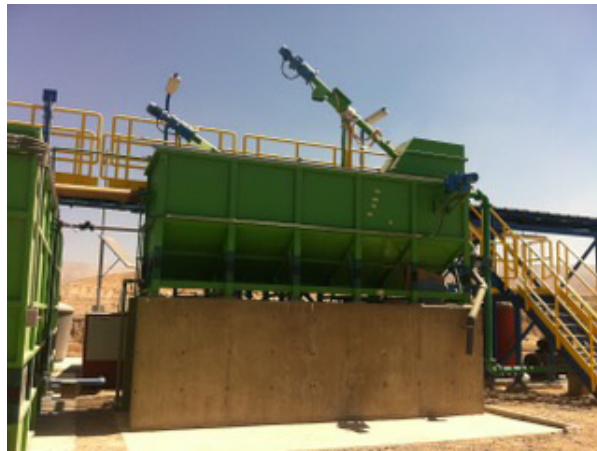
Diseño, fabricación, montaje y puesta en marcha de PPTC. Cliente: CODELCO Proy. Mina Chuquicamata Subterránea.
