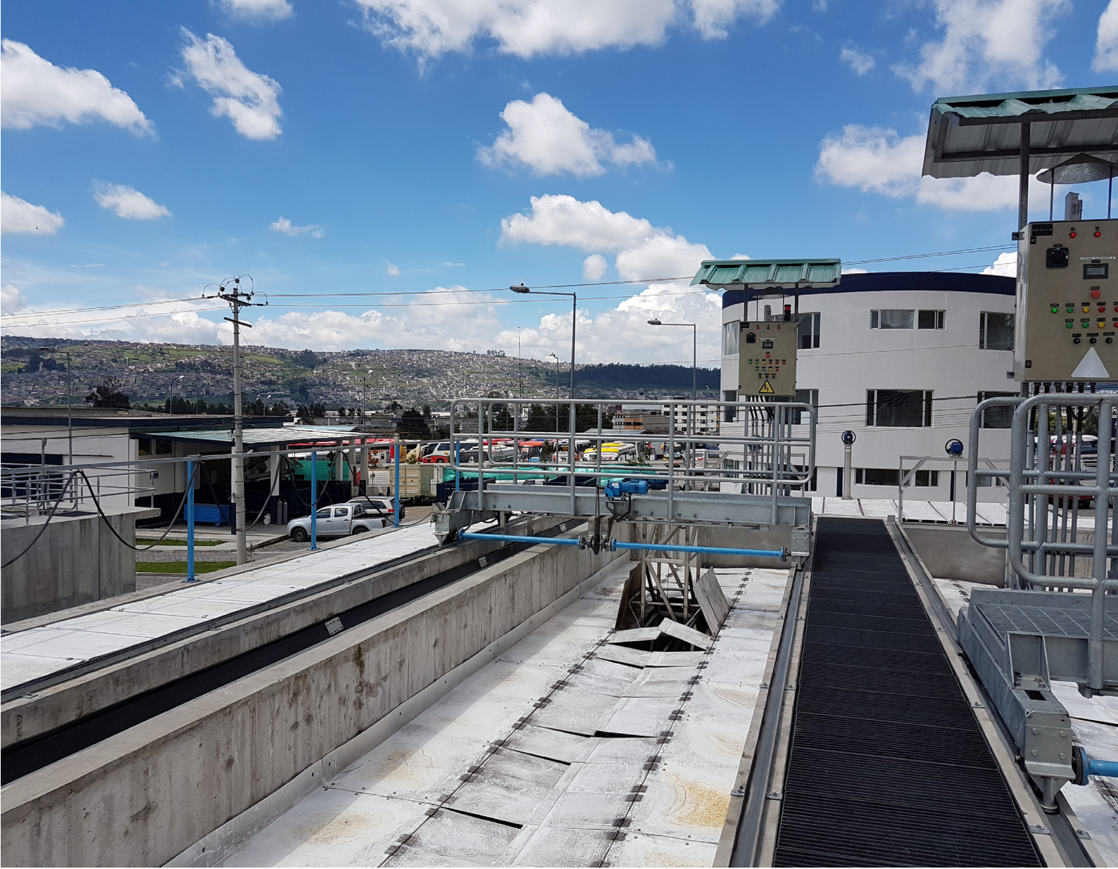
• PUENTE BARREDOR LONGITUDINAL
